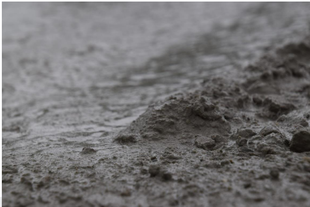
Foto: Detailopname betonmortel.
