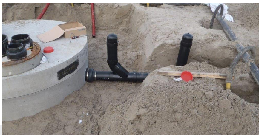
Foto: Voorbeeld van voorzieningen voor controle van de bedrijfsriolering op waterdichtheid. Aansluiting van de bedrijfsriolering (hdpe) op de prefab betonnen sli vangput.
